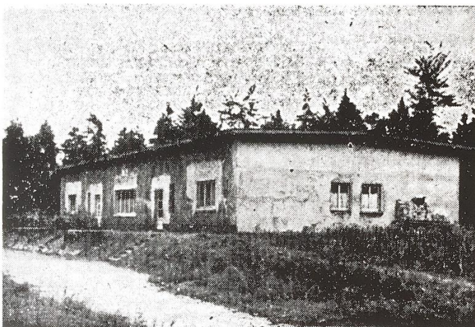
Abbildung 7 Umgebaute Lagerhalle in Schelenhorst (Tapke-Jost, o.A., S.539)
