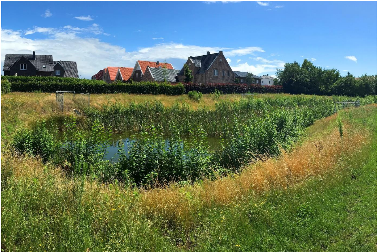
Abb. 12: Regenrückhaltebecken im Wohngebiet Telbraker Esch
